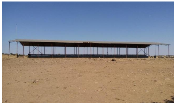
Figura 24 - Zona de ensombramento existente (c1) no Pa33
