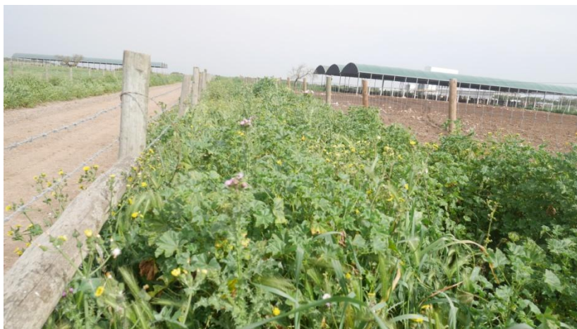
Figura 55: Vedação existente em ambas as margens de uma vala de drenagem.
