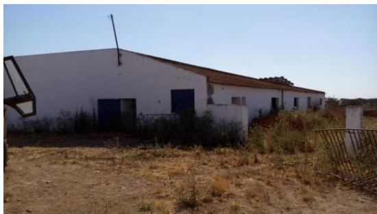
Figura 20 - Parque de resíduos (a6)
