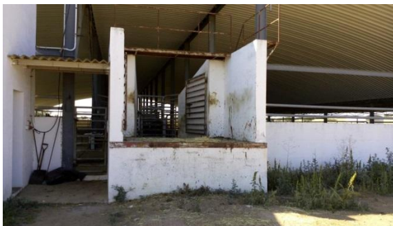
Figura 29 – Cais de carga-descarga junto à zona de manejo (C4)
