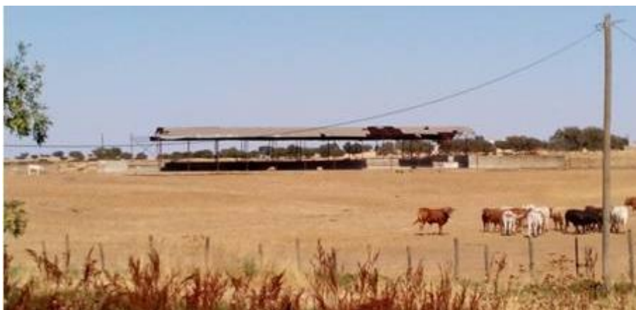
Figura 89 – Telheiro de ensombramento (parque de engorda-crescimento, existente na Herdade do Trolho)
