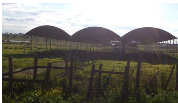
Figura 27 - Zona de ensombramento existente (c2) nos Pe1 a Pe12
